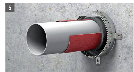
Am Ende des Metallbandes 2 Nasen um 90° umbiegen, das das andere Ende des Metallbandes durch Einführen der umgebogenen Laschen in die waagerechten Aussparungen der anderen Bandseite miteinander verbinden und die Laschen abschließend wieder umbiegen, sodass das Band fest miteinander verbunden ist.
