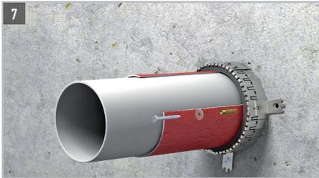
Jeden Befestigungspunkt mit entsprechend zugelassenen Dübeln an der Wand / unter der Decke befestigen.
